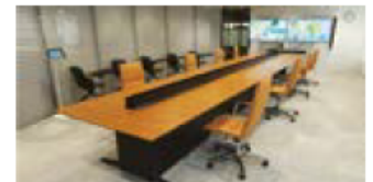
Sitzungssaal des Verwaltungsrats, ausgestattet mit dem System ADECIA und AIRTRIEVE
